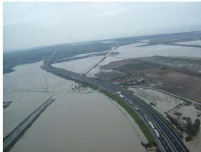
Evento alluvionale marzo 2005: allagamento sottopasso SS16
