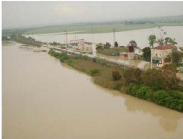
Evento alluvionale aprile 2009: allagamento FF.SS.
