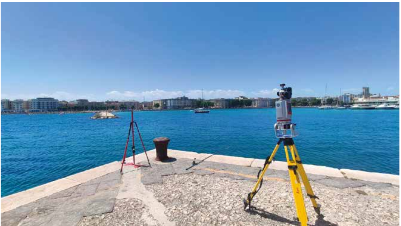
Figura 2.4 - Fasi del rilievo laser scanner Porto Vecchio Bari ( PRISMA srl )
