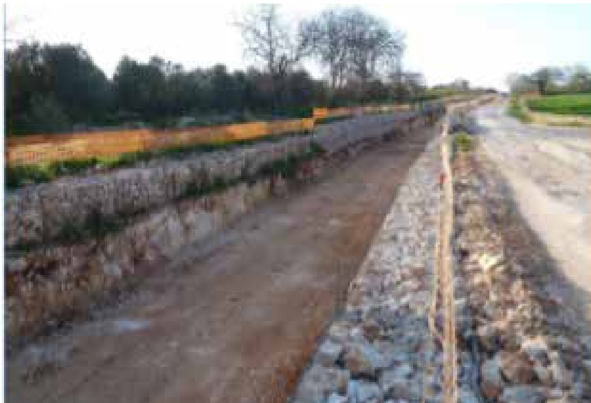
Lavorative di scavo del canale deviatore
