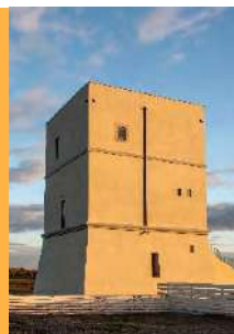
Torre Pietra Margherita di Savoia, Bat 1568
